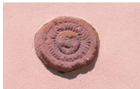
Détail de l'anneau solaire situé sur le mur de la sacristie de l'église.
