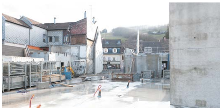
Vue arrière du chantier
