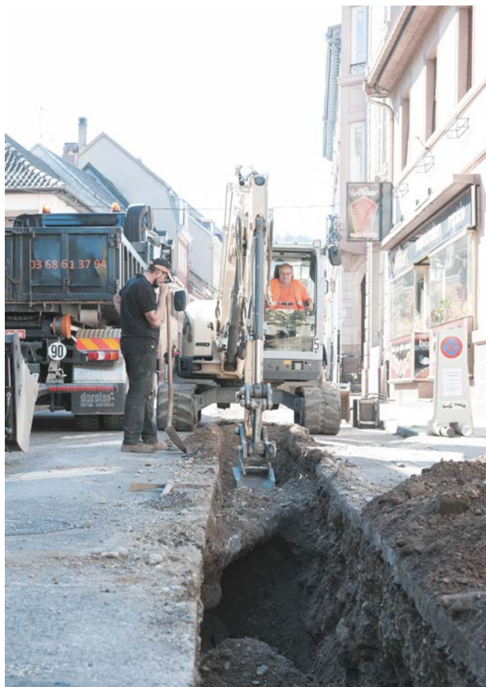
Dégagement d'une conduite d'eau
