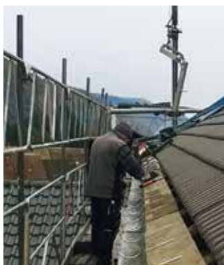
Rénovation de la toiture
